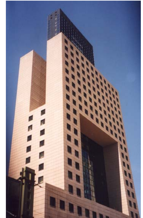
Messe-Torhaus, 115 m Lochfassaden
