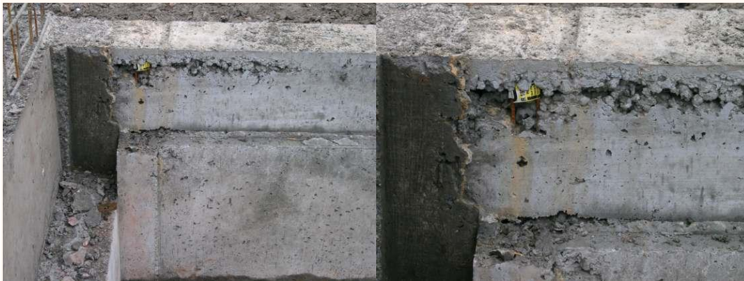
Qualitätsbeton, Deutschland, 21.Jahrhundert
